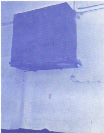
CO2 LIFE JACKET LOCKER (HANGAR BAY)
